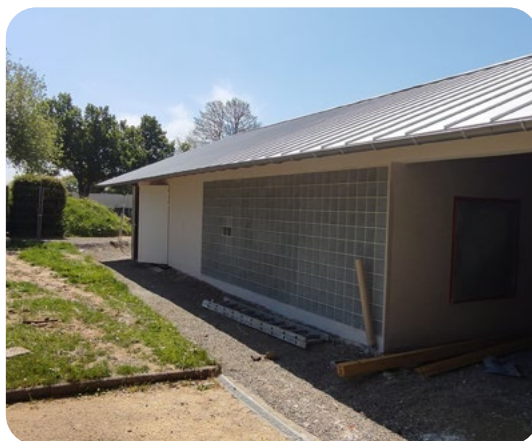
Le coût des travaux de la nouvelle construction à l'entrée du cimetière s'élève à 289 000 € HT.
