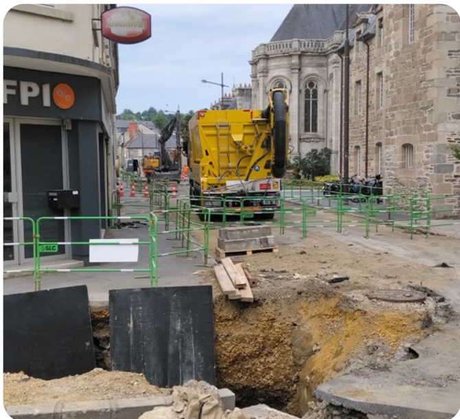
Les travaux ont débuté fin mai dans la rue de Kerampont.
