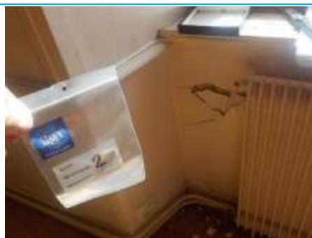
Matériaux : ZPSO-002 Prélèvement : P002 Description : Enduit murs Localisation : 1er étage - Pièce 3 Résultat : Absence d'amiante
