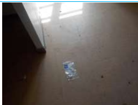
Matériaux : ZPSO-004 Prélèvement : P004 Description : Dalle de sol Localisation : 2ème étage - Salle de bain Résultat : Absence d'amiante
