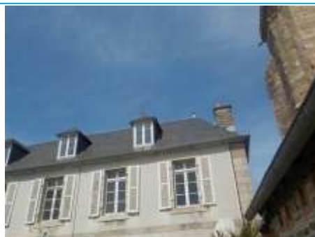
Matériaux : ZPSO-015 Prélèvement : Description : Ardoises naturelles Localisation : Parties extérieures: Toiture prebytère Résultat : Absence d'amiante
