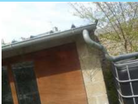
Matériaux : ZPSO-010 Prélèvement : Description : Conduit d'eaux pluviales zinc Localisation : Cabanon 2 - Cabanon 2 Résultat : Absence d'amiante
